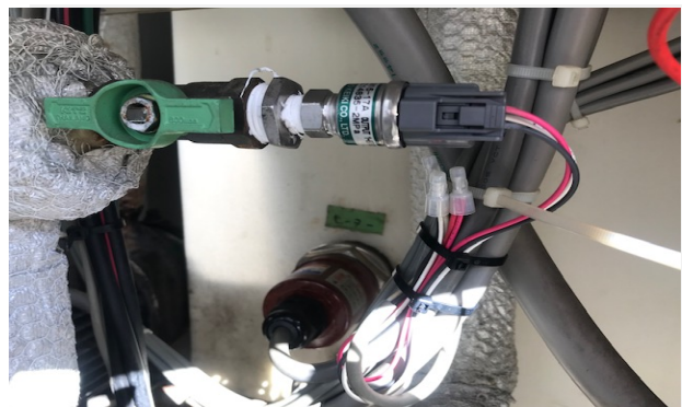
送媒圧力センサー交換後
