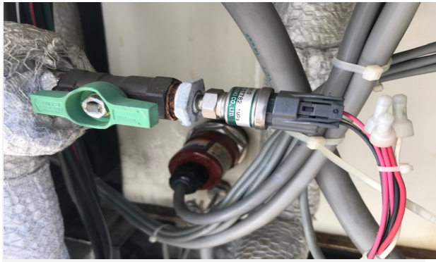
送媒圧力センサー交換前
